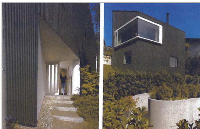
Bruk av kontrastfarge i inntrukne/utskutte parti i fasaden
