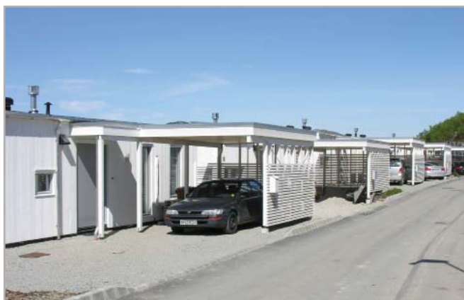
Enhetlig fargebruk og materialbruk i bygg og carport
