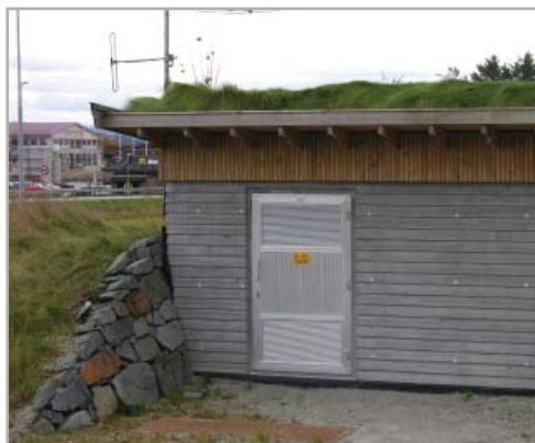
Større trafo av betong og tre med grastak.
